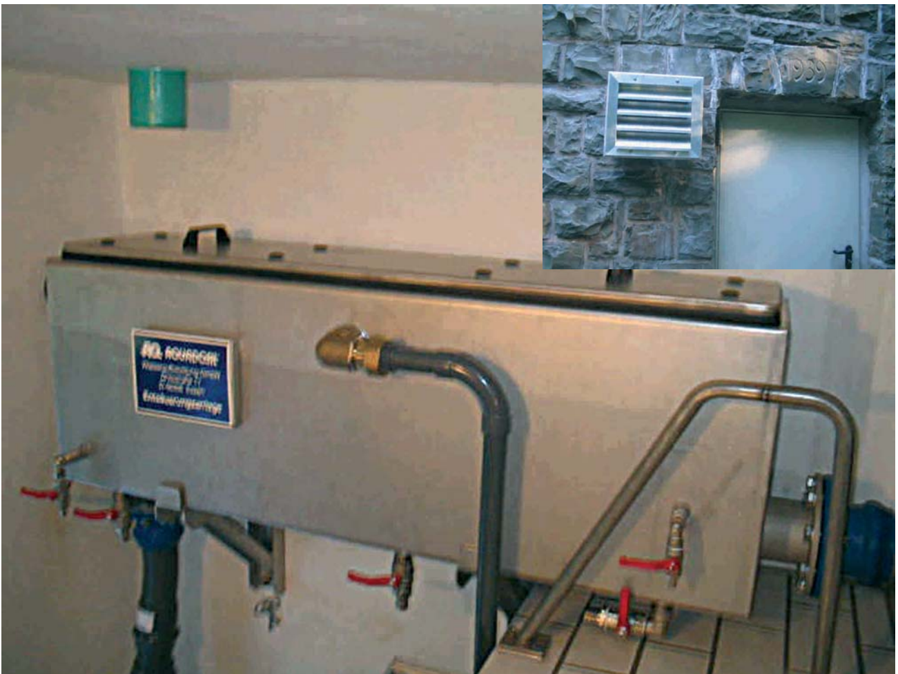
Die benötigte Luft für die Entsäuerungsanlage wird von außen angesaugt und anschließend wieder nach draußen geblasen.
