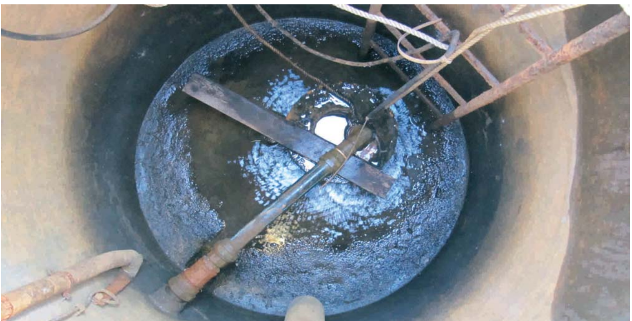
Reinigungsversuch des sogenannten Cadmiumbrunnen
