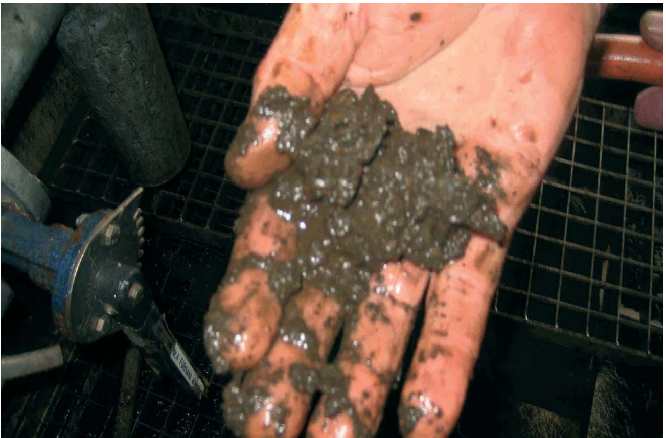
Reinigung der Saugheberleitung
