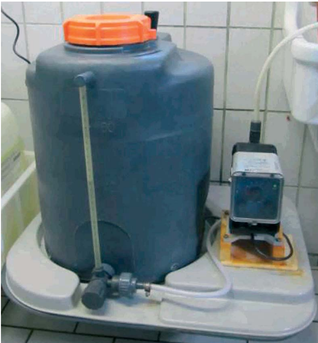
Chlordosierungs- anlage
