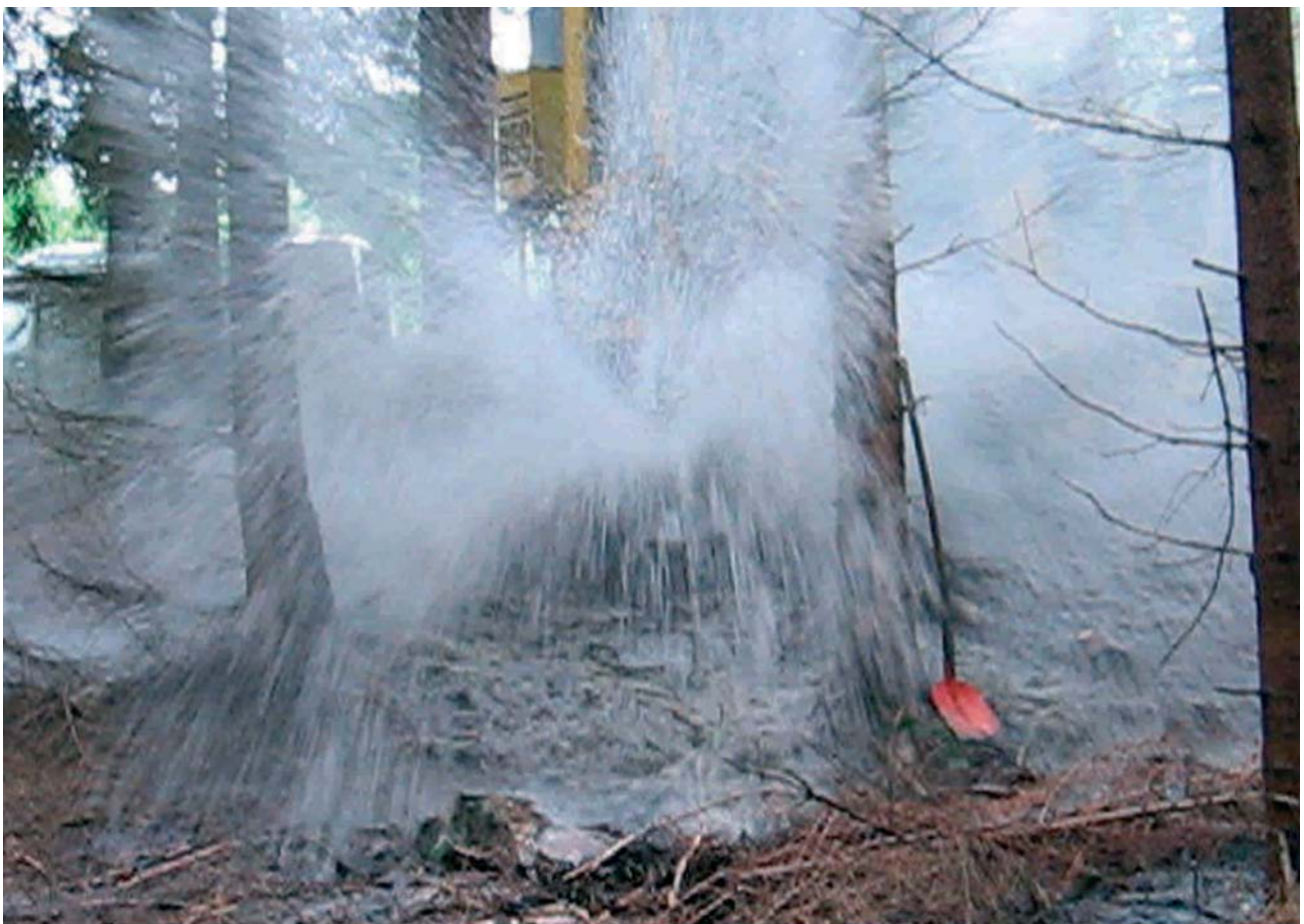
60 Meter tief wurde der Brunnen gebohrt und mit PreBluft gespült.
