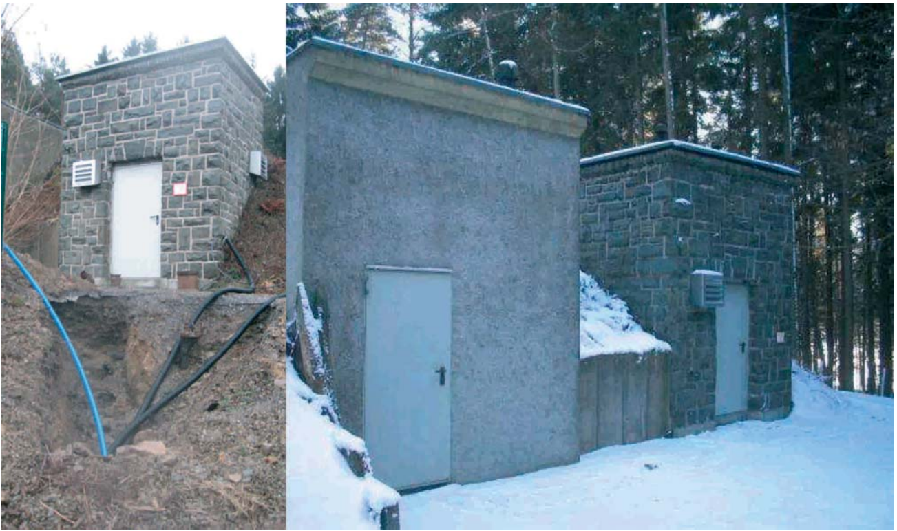
Hochbehälter Op'm Knappe im Winter. Links, Verlegung der neuen Druckleitung.
