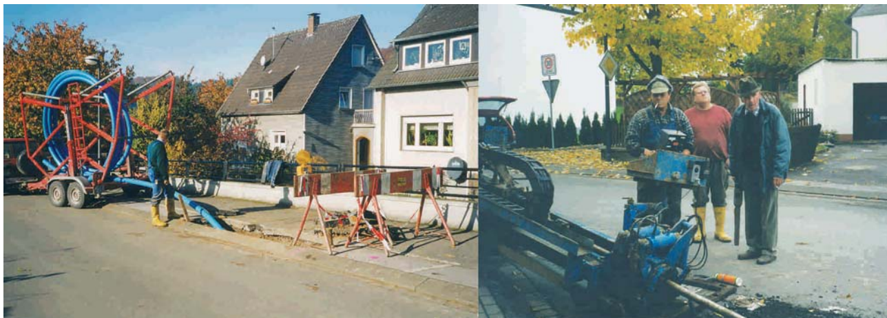
Grabenloser Rohrverbau an der Balver Straße 1999
