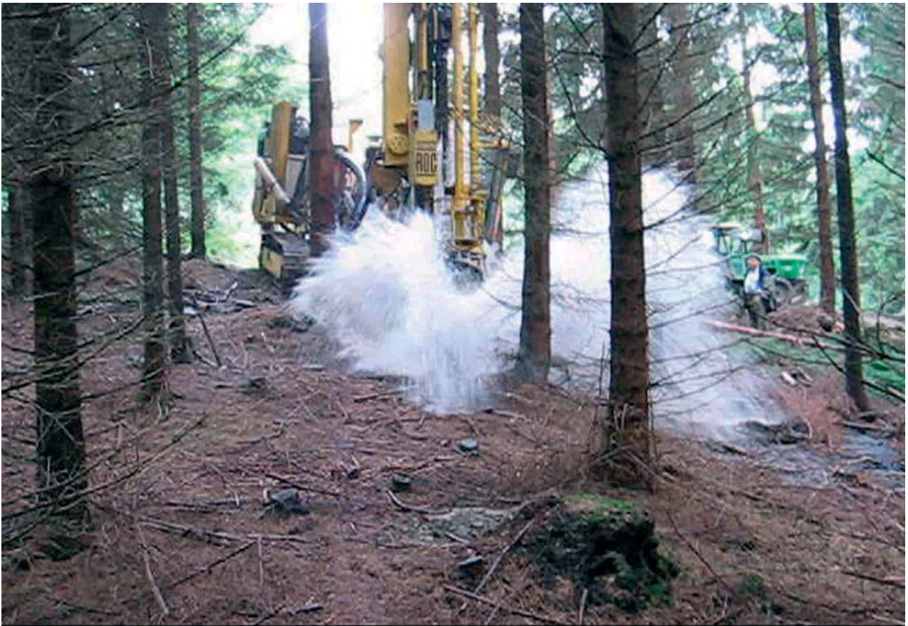
Nach 18 Meter Bohrtiefe kam das erste Wasser aus dem Bohrloch des Notbrunnens.
