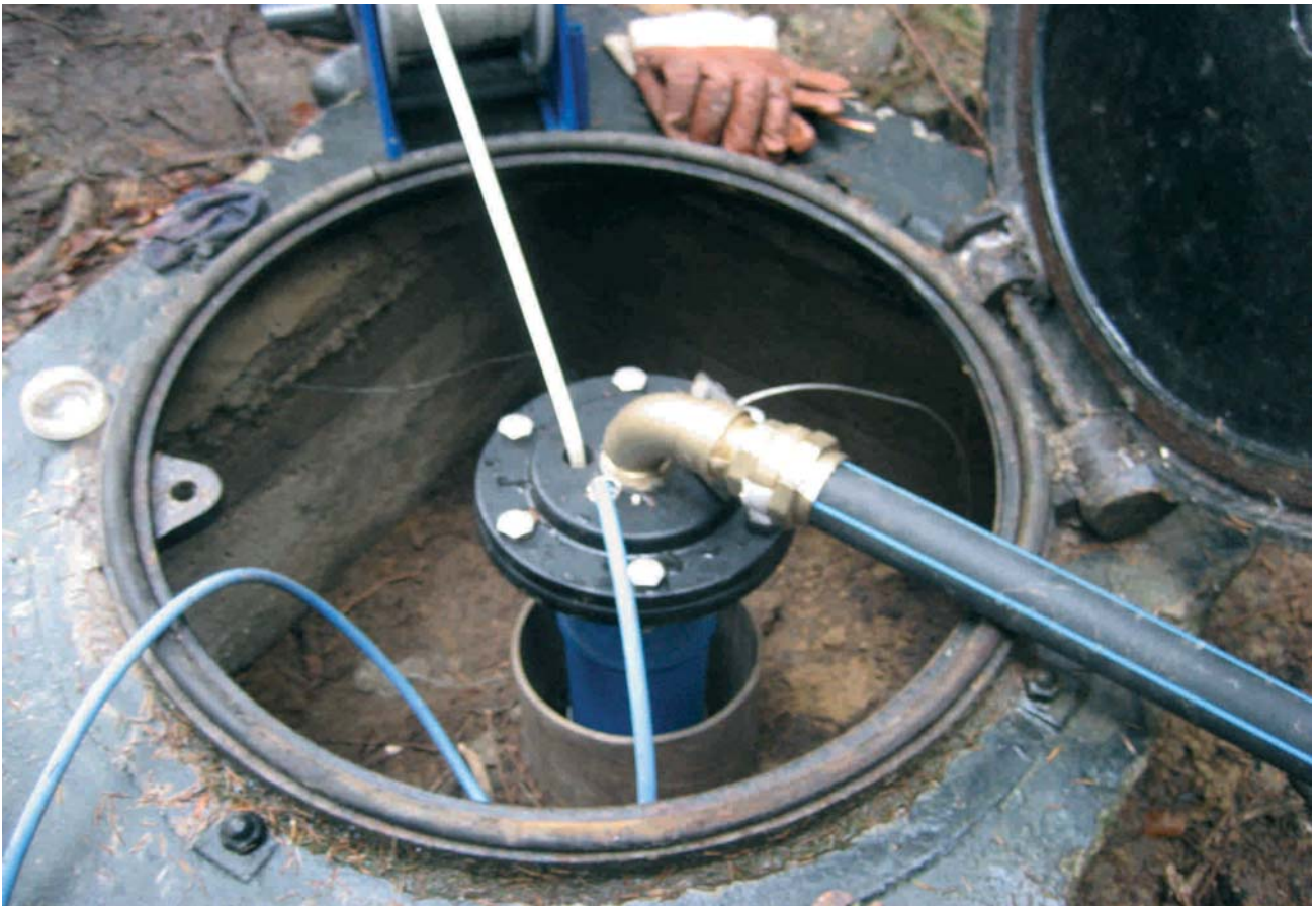
Test mit Lichtlot beim Abpumpen des Wassers. Der abgesenkte Wasserspiegel hielt sich in Grenzen.
