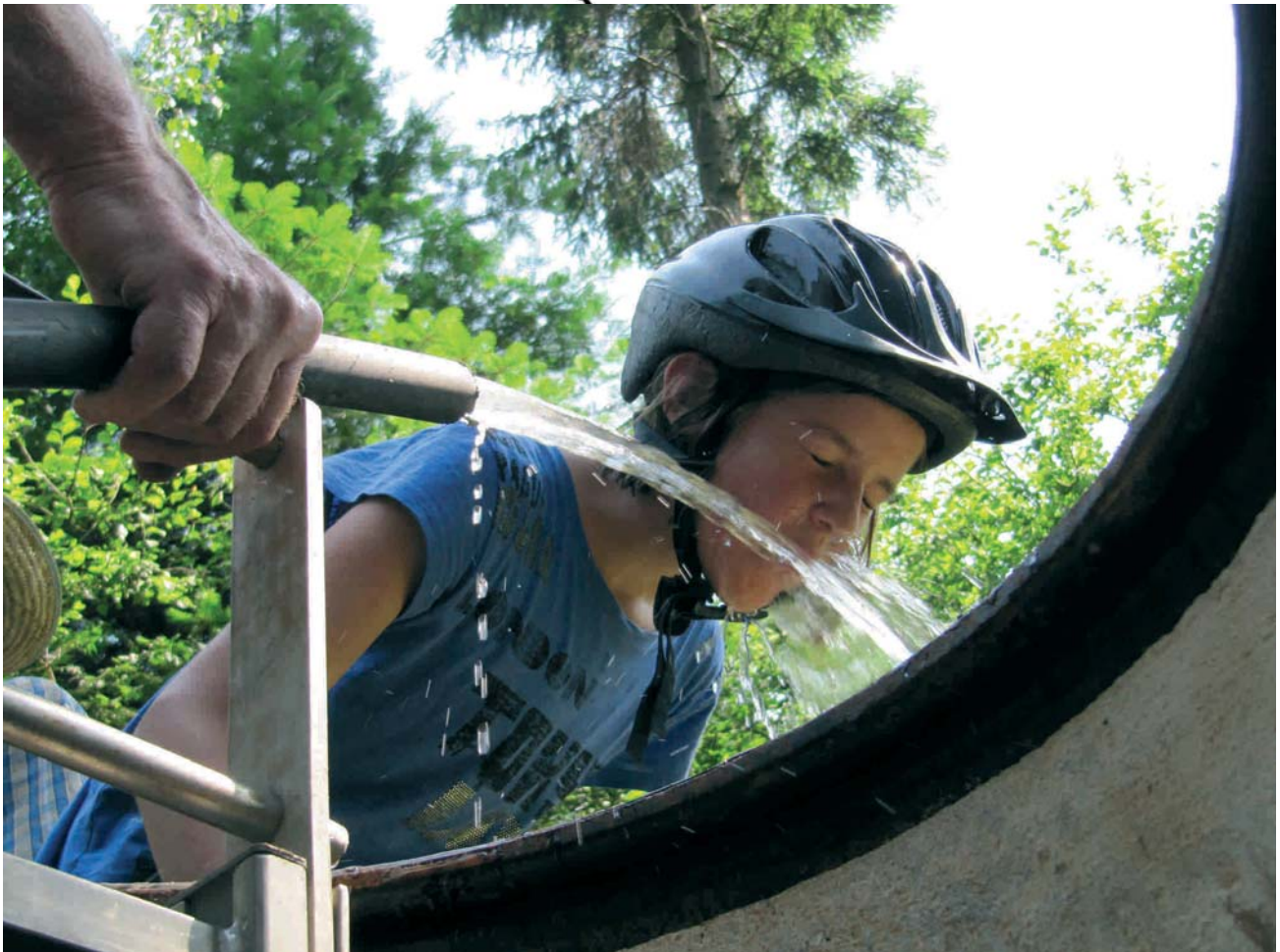
Tiefbrunnen „Op'm Knappe“: Lecker, sauber reines Trinkwasser, ...
