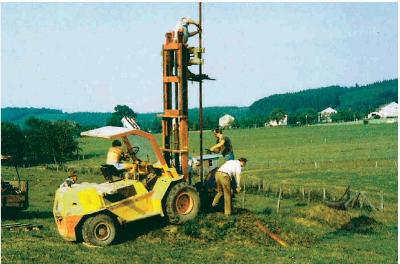
Reinigungsarbeiten am Tiefbrunnen an der Orle, wurde 1989 geschlossen
