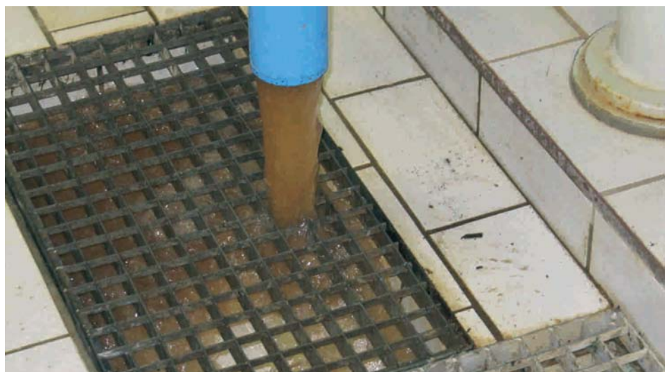
Rückspül-Radialgebläse. Das Rückspülwasser wird dem Abwasserkanal zugeführt.
