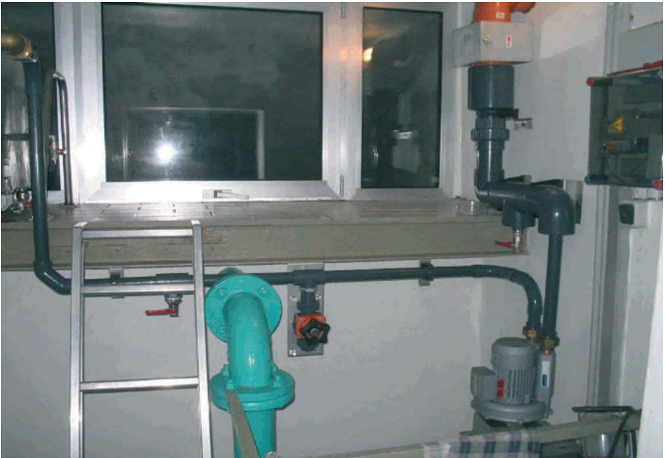
Die benötigte Luft für die Entsäuerungsanlage wird von außen angesaugt und anschließend wieder nach draußen geblasen.
