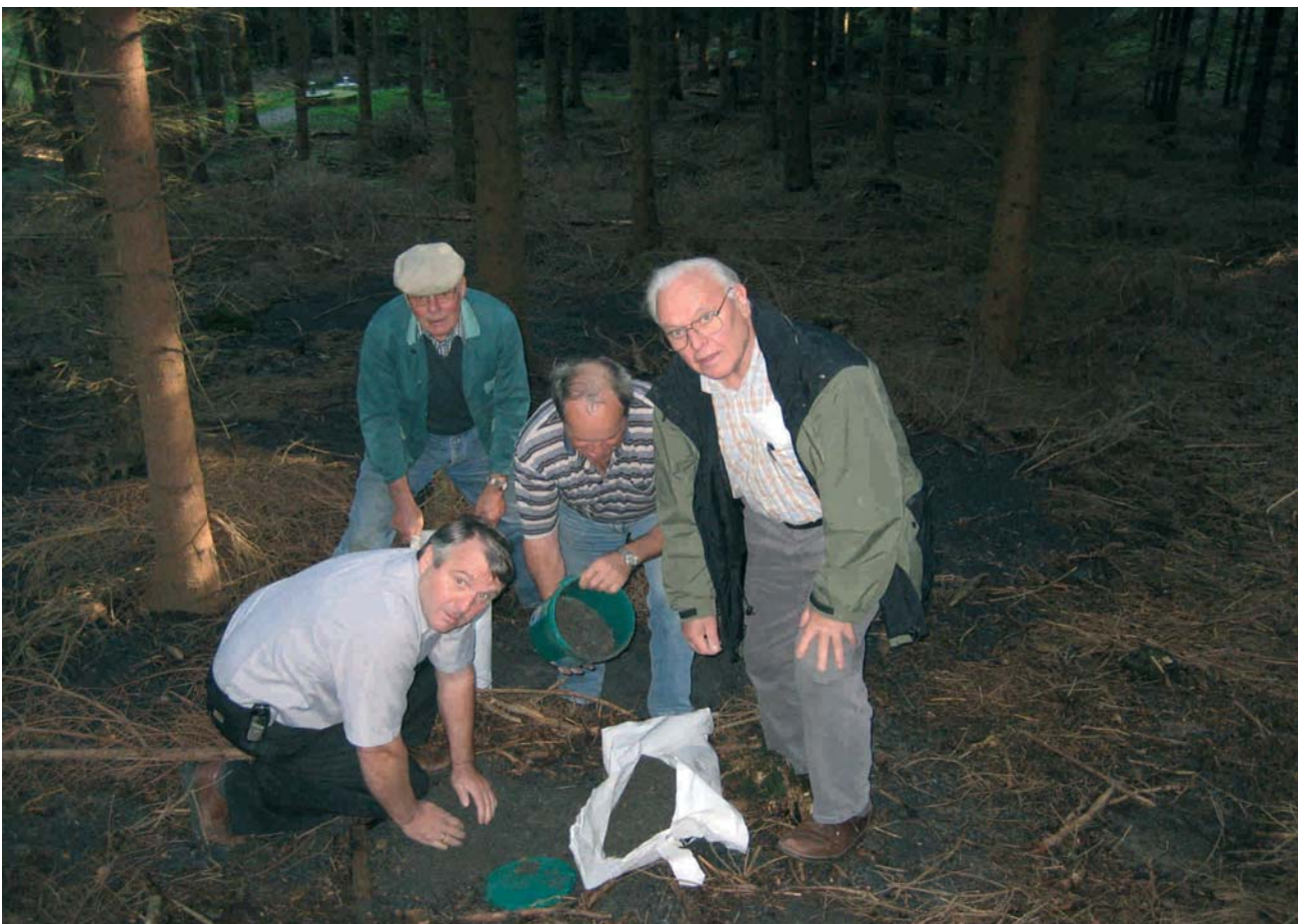
Der Ausbau des Bohrloches mit geschlitzten Rohren und Ummantelung mit Filterkies erfolgte z.Teil in Eigenleistung
