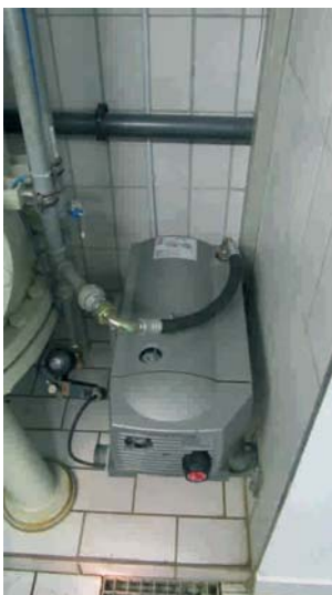
Rückspül-Radialgebläse. Das Rückspülwasser wird dem Abwasserkanal zugeführt.
