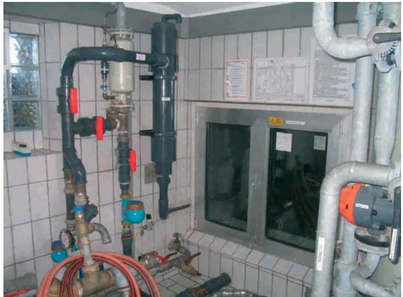
Brunnenwasserzuläufe in Verbindung mit Luftmischanlagen.
