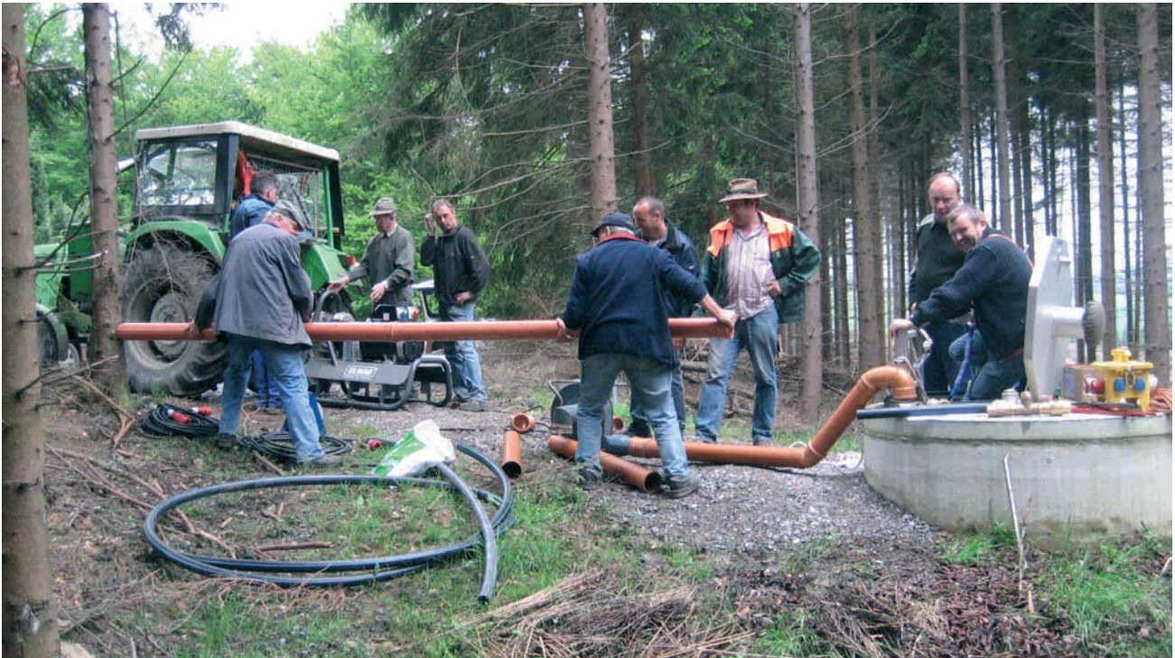
Arbeitseinsatz am Notbrunnen – Installation der Schachtbelüftung
