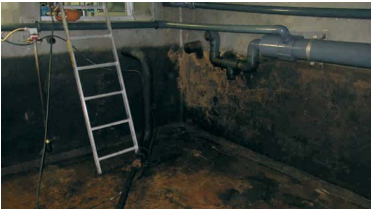
Die beginnende Ausfällung im Sammelbehälter hat den Nachteil des häufigen Reinigens.
